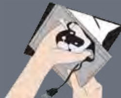
2. Remove old fan assembly
